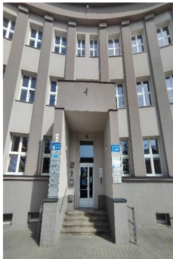
vstup do budovy
